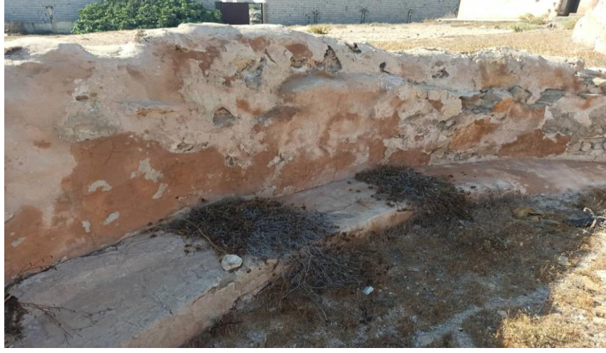
شكل (12)، تأثير الرطوبة المباشر على أسوار الدار
