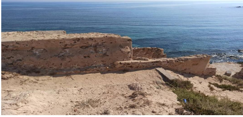
شكل (8), تأثير مياه البحر مباشرة على أسوار الدار
