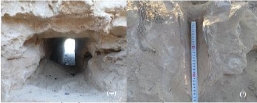
(الصورة 2) (أ) قناة إمداد حوض التصفية (ب) الفتحة الرئيسية لإمداد الخزان الشمالي بالمياه القادمة من حوض التصفية.
