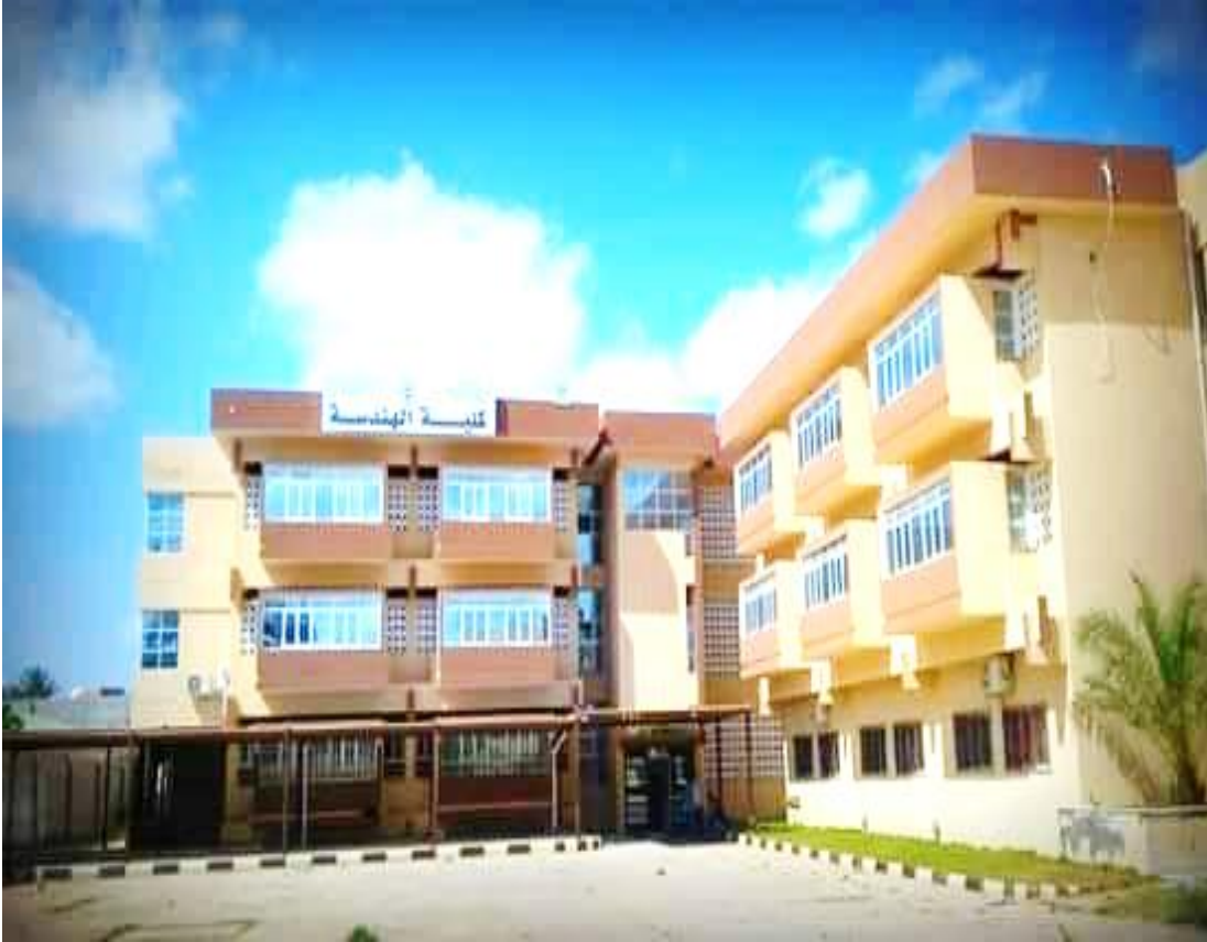
مبنى كلية الهندسة
