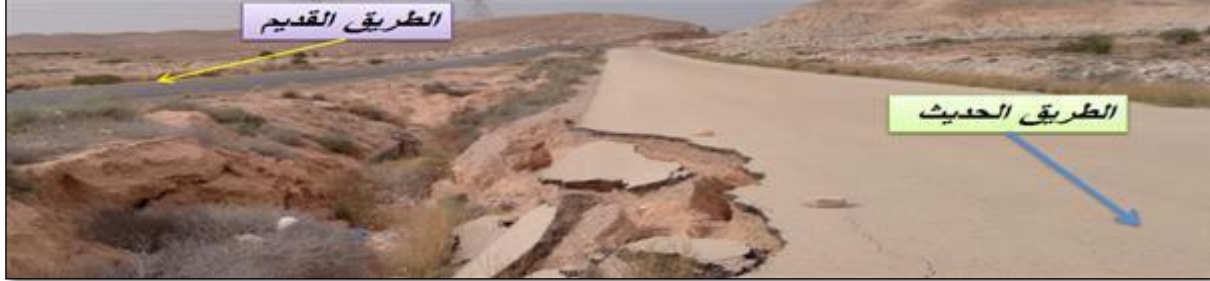
شكل 8 انهيار الطريق بالموقع L-BA-21-d
