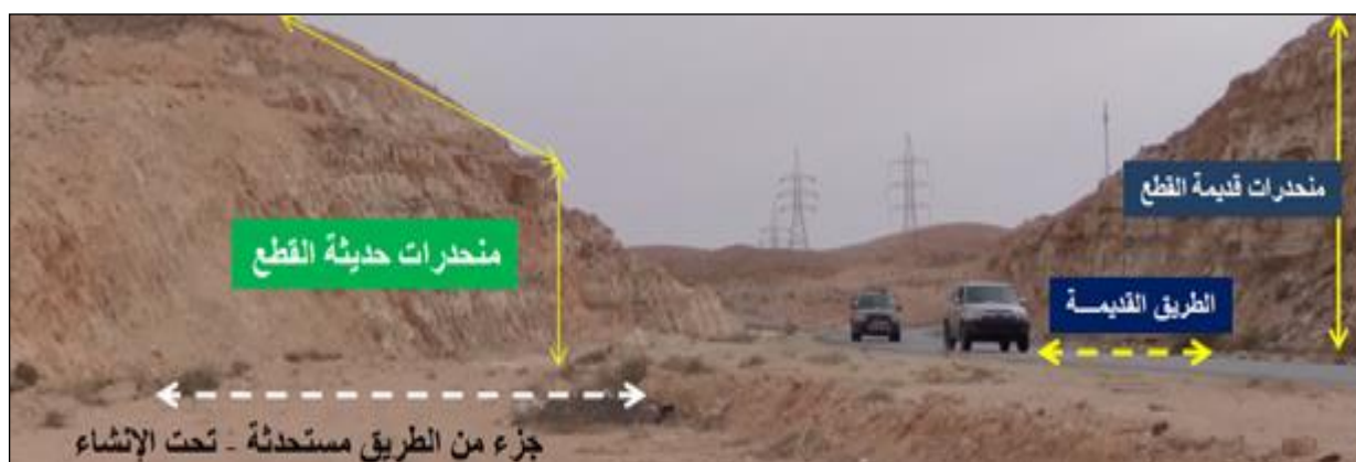
شكل 1 جزء من المنحدرات المقطوعة لغرض توسعة مسار الطريق القديم
